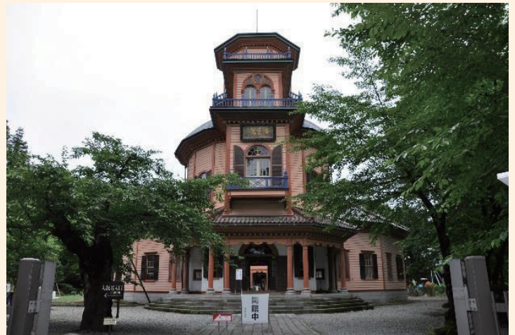
旧済生館本館(現市郷土館)
